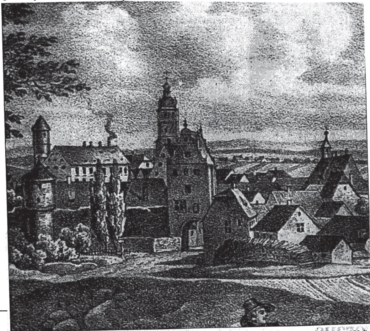
Im März 1872 wurde in Dettelbach das Steigtör abgebrochen, das in einer Stadtansicht aus dem Jahre 1850 (im Bild ein Ausschnitt) noch in seiner stattlichen Größe erkennbar ist.
